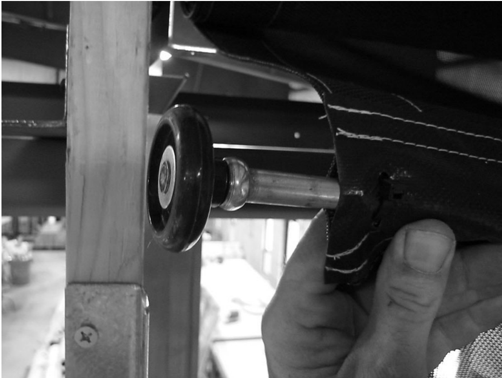
Foto #14 (instalación del rodillo)
