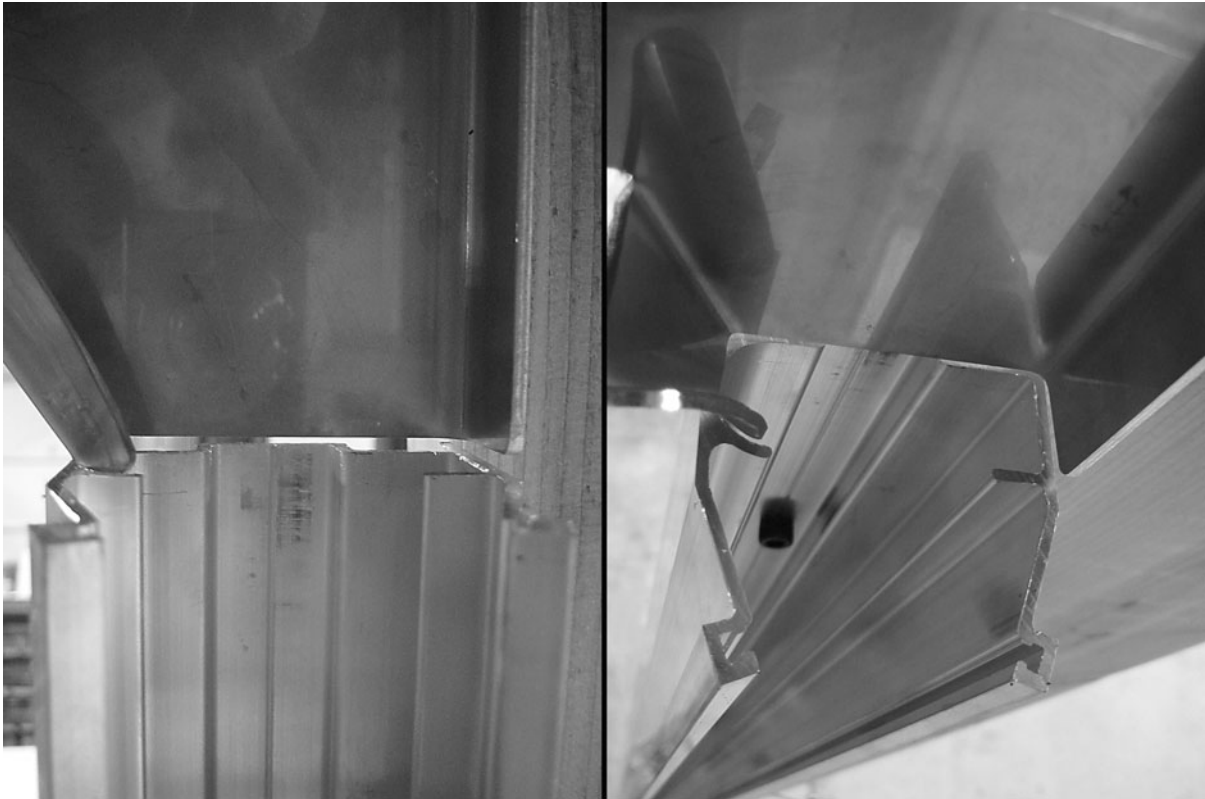
Foto #2 (Alineación del soporte a la la protuberancia)
