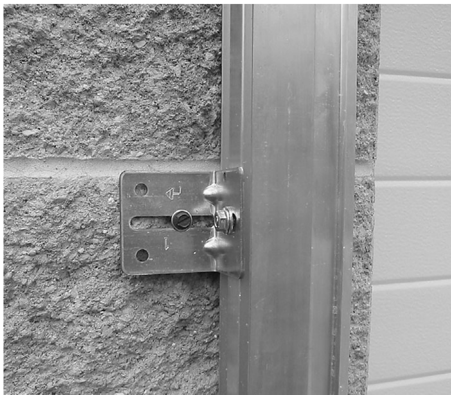
Foto #1 (Soporte de ángulo montado a la protuberancia)
